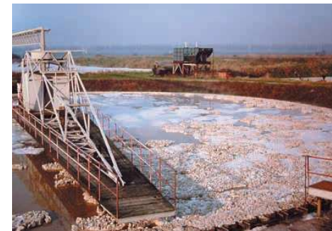
In zogenaamde 'sterfputten' werd het vervuilde water opgevangen | © Steenbergse Courant
