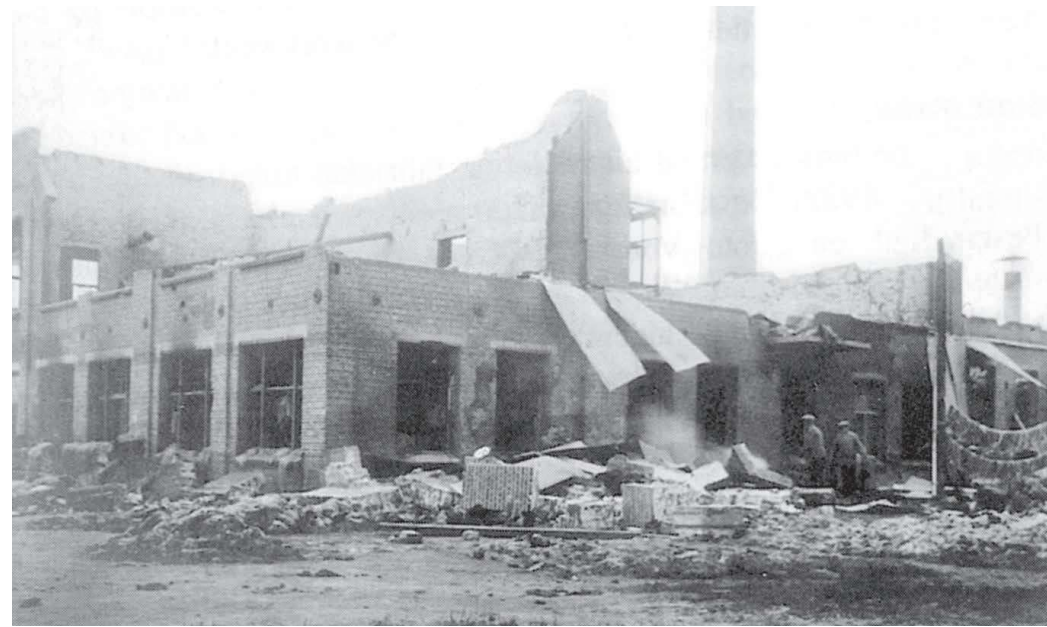
De Vlasfabriek na de brand in 1925 | © archief De Steenen Kamer
